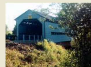
Pont couvert des Draveurs à Mont-Label, route du Lac-à-Quenon, sur la Petite rivière Neigette. Sa construction remonte à 1930.
